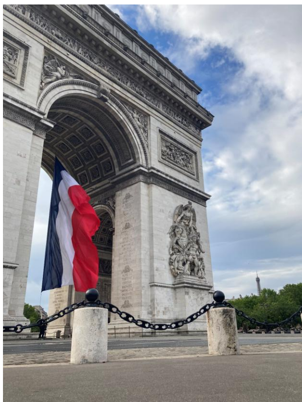
Façade Ouest de l'Arc de triomphe et le grand pavois sous la grande voûte © DR / Centre des monuments nationaux
